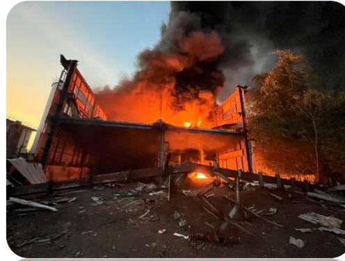
โรงงานสารเคมีไฟไหม้
